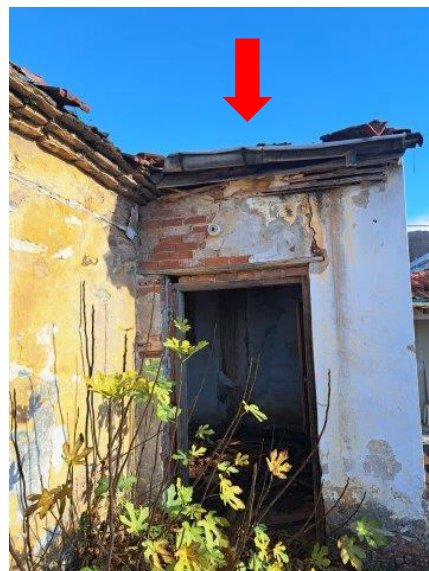
Φωτ 8-9: Αριστερά: Λεπτομέρεια προσθήκης εσωτερικό (βύθιση στέγης) Δεξιά: Λεπτομέρεια προσθήκης εξωτερικά (βύθιση στέγης)
