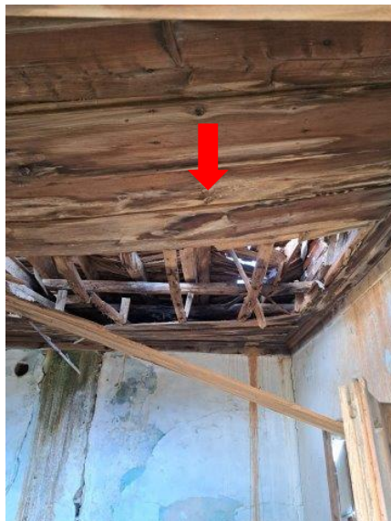
Φωτ 8-9: Αριστερά: Λεπτομέρεια προσθήκης εσωτερικό (βύθιση στέγης) Δεξιά: Λεπτομέρεια προσθήκης εξωτερικά (βύθιση στέγης)
