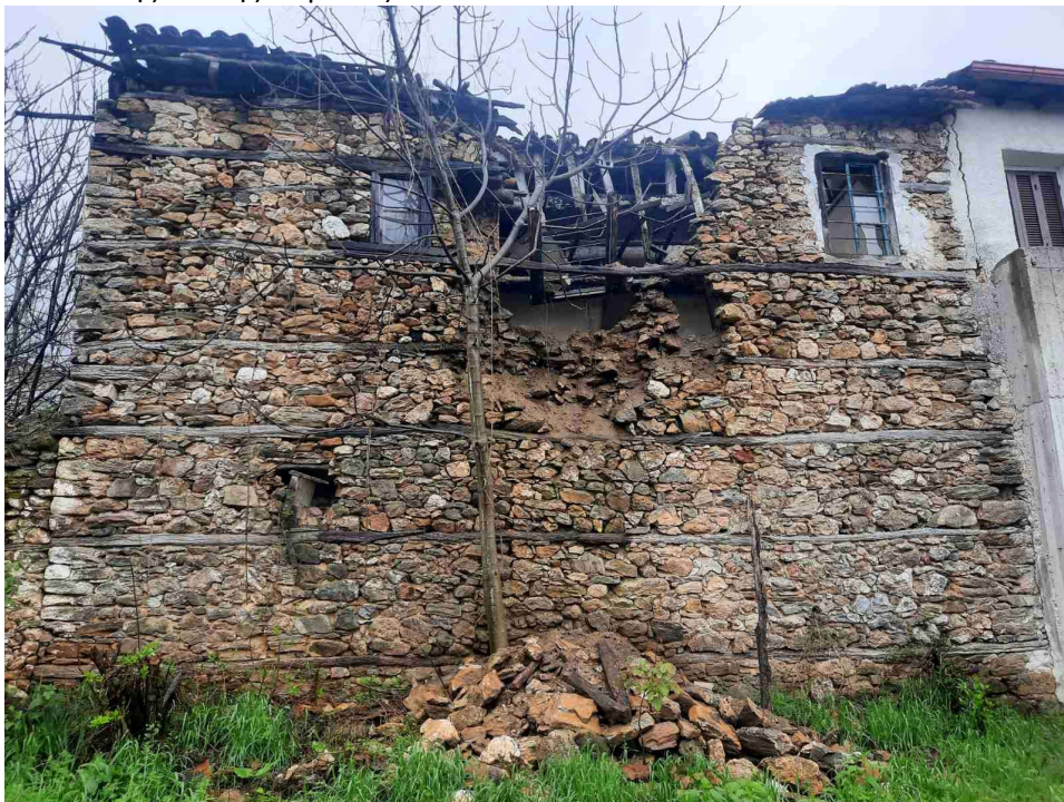
Φωτ. 2 Η βόρεια πλευρά του κτίσματος
