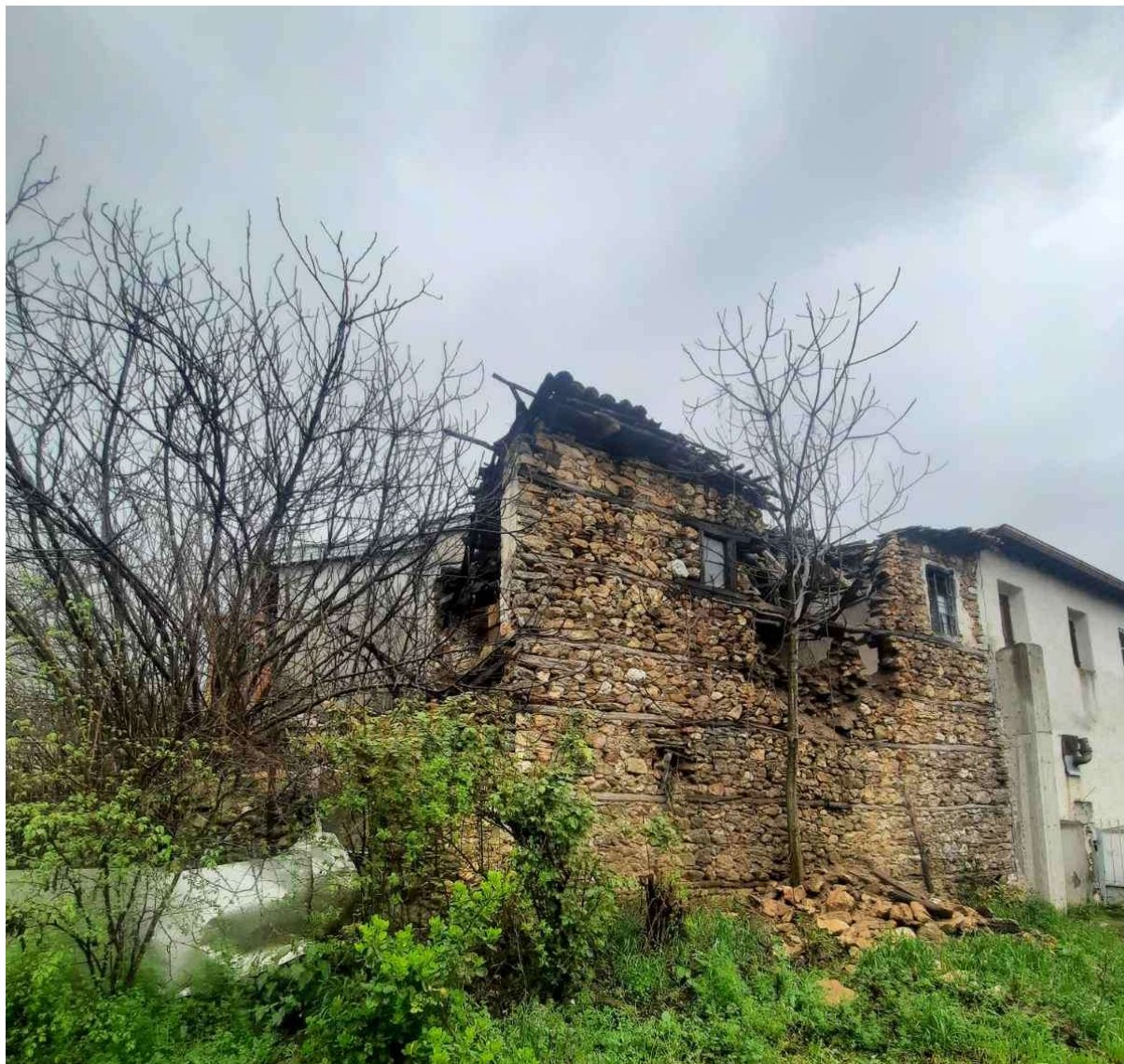
Φωτ. 3 Η βορειοδυτική πλευρά του κτίσματος
