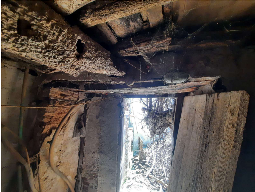
Φωτ. 8 Εσωτερικό ισογείου του τμήματος Γ
