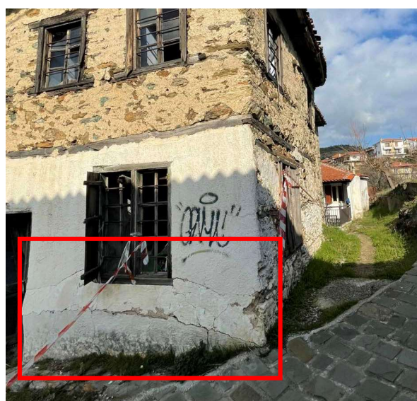
Φωτ. 8 Αριστερά βύθιση του παραθύρου του ισογείου από την πλευρά Α και Φωτ 9 Απόκλιση από την κατακόρυφο της πλευράς Β.
