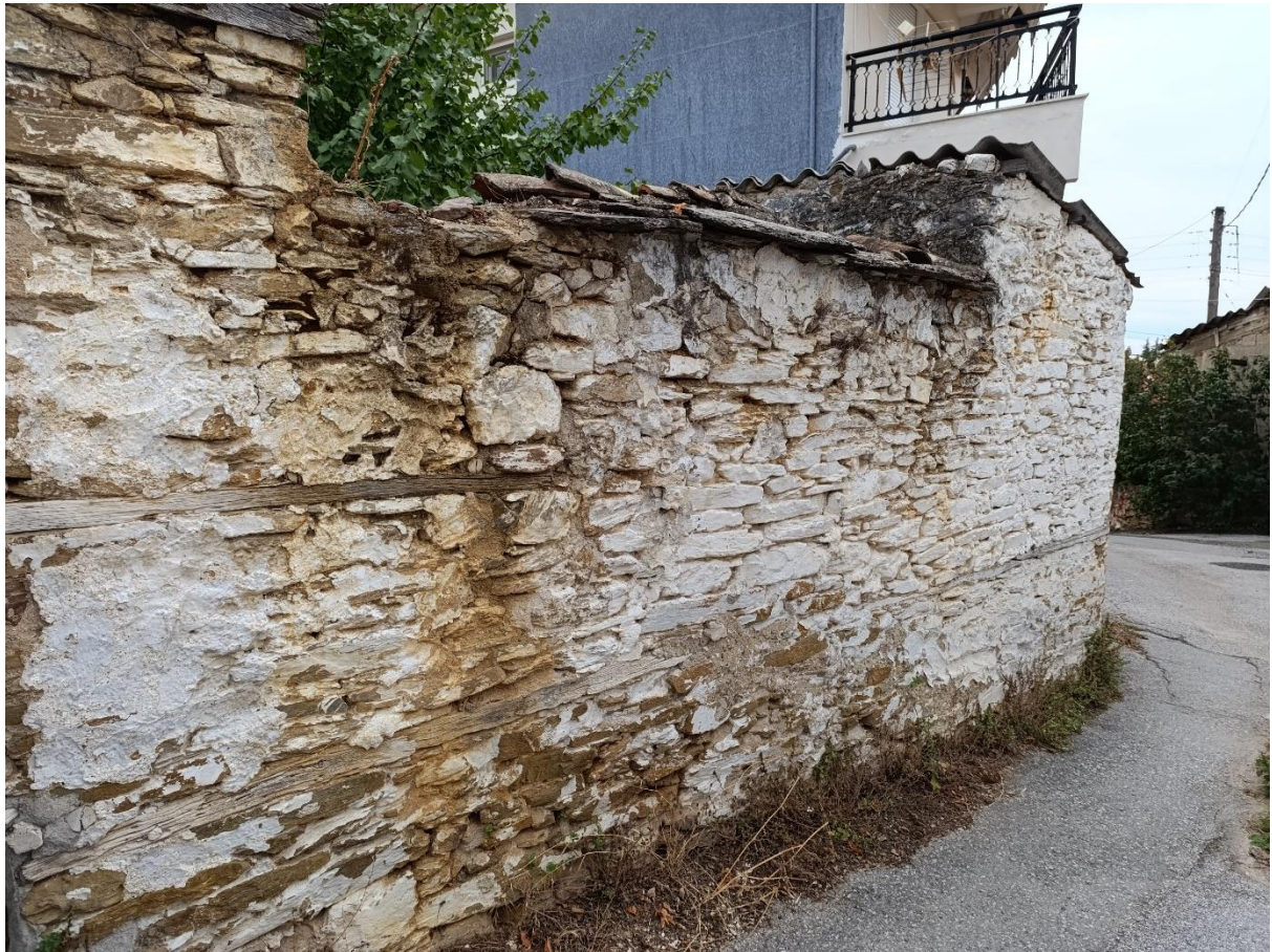
Φωτ. 7 Ο τοίχος του περιβόλου από τη δυτική πλευρά
