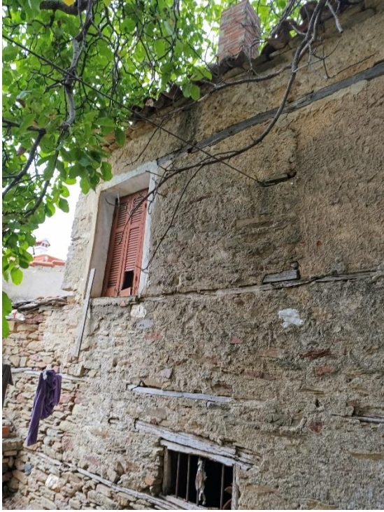
Φωτ. 5 & 6 Αλλοιώσεις της λίθινης τοιχοποιίας από την ανατολική πλευρά
