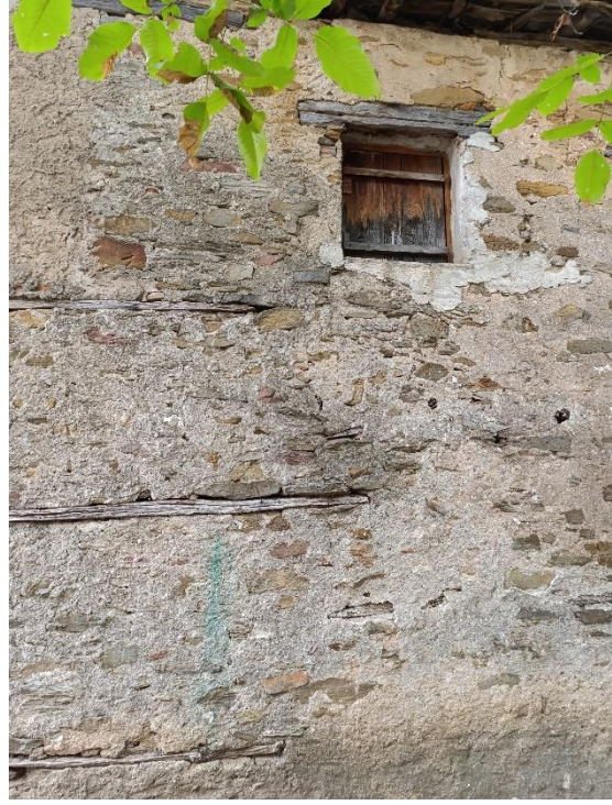
Φωτ. 5 & 6 Αλλοιώσεις της λίθινης τοιχοποιίας από την ανατολική πλευρά
