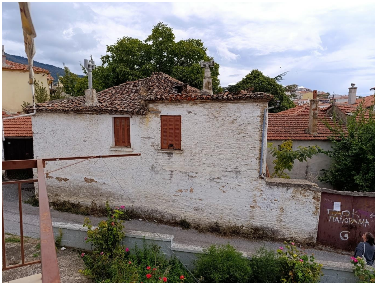
Φωτ. 2 Η δυτική όψη του κτίσματος επί της κύριας οδού
