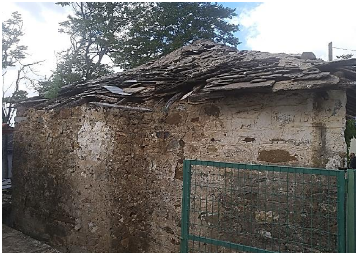
Φωτ. 3 Πλάγια όψη του κτίσματος
