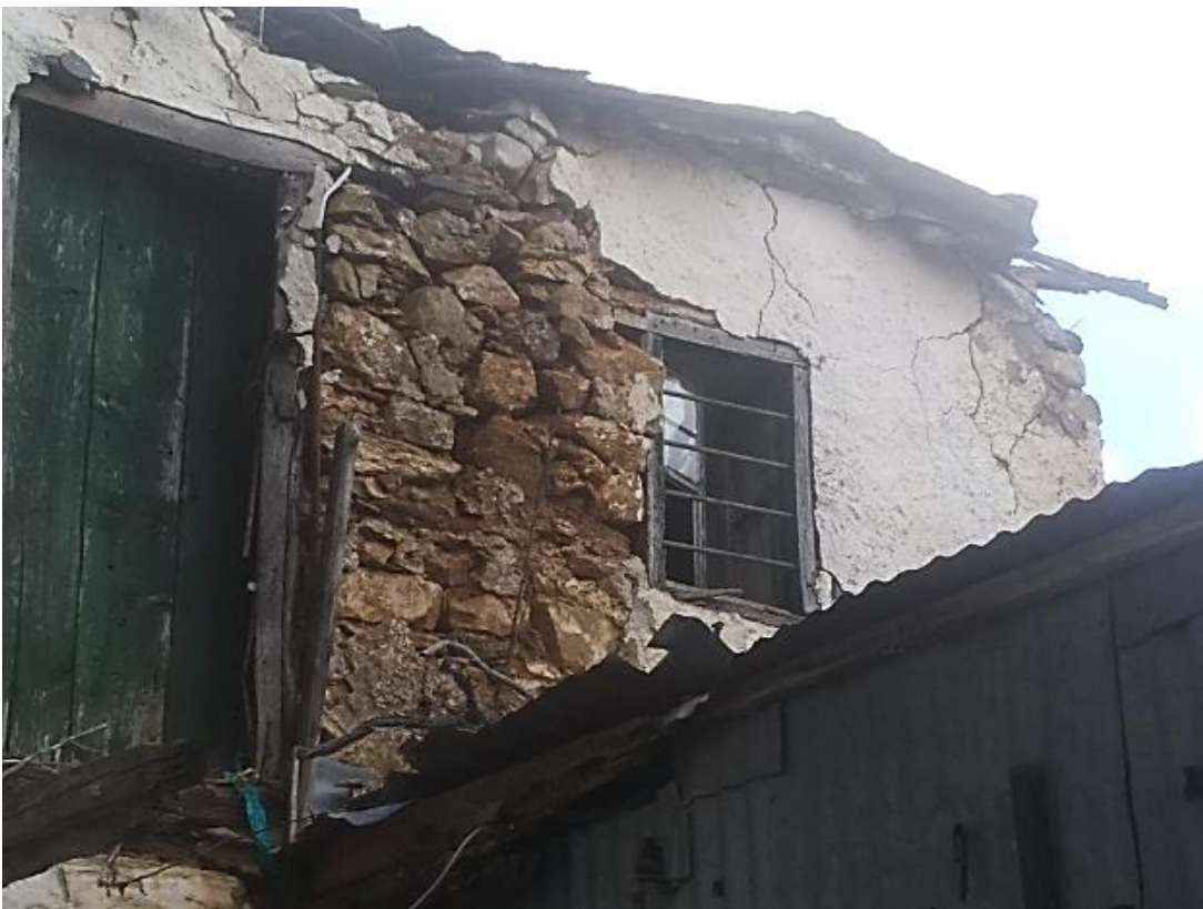
Φωτ. 6 Λεπτομέρεια της κατασκευής
