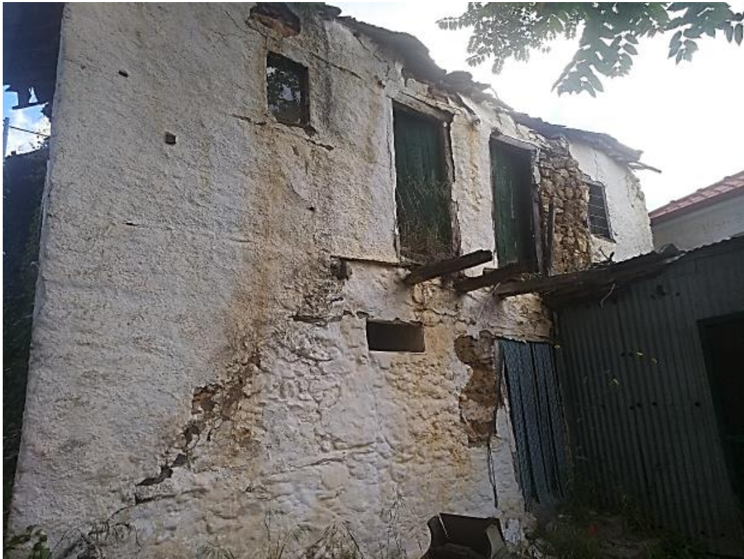
Φωτ. 5 Η νοτιοδυτική όψη του κτίσματος
