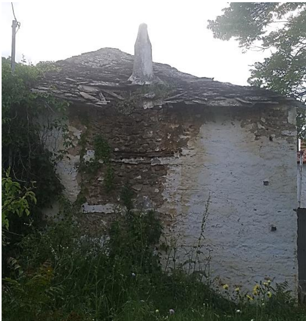
Φωτ. 4 Πλάγια όψη του κτίσματος
