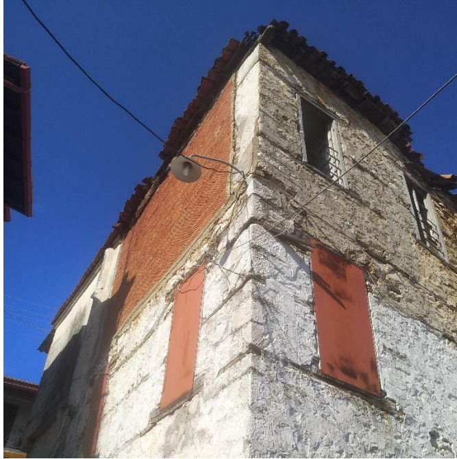
Φωτ.6 Λεπτομέρεια της βορειοδυτικής γωνίας. Αριστερά πάνω η προσθήκη σενάζ και η πλήρωση τοίχου με πλινθοδομή. Δεξιά πάνω η στρέβλωση της κατακόρυφωσης του τρίτου ορόφου. Κάτω απόκλιση του βόρειου τοίχου από την κατακόρυφο.
