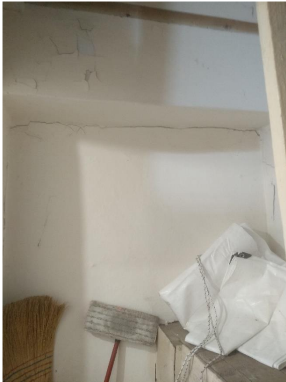
Φωτ.7 Λεπτομέρεια εσωτερικού με ρηγματώσεις σε τοιχοποιίες και οροφή από το δυτικό τμήμα της νότιας πλευράς
