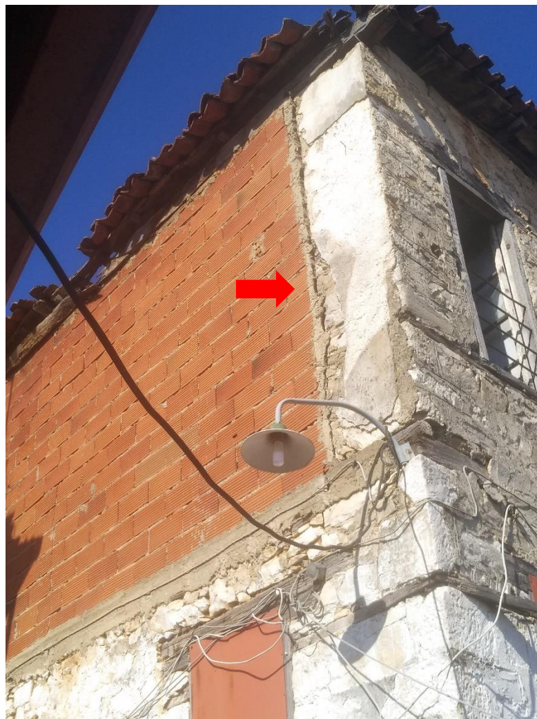
Φωτ.6 Λεπτομέρεια της βορειοδυτικής γωνίας. Αριστερά πάνω η προσθήκη σενάζ και η πλήρωση τοίχου με πλινθοδομή. Δεξιά πάνω η στρέβλωση της κατακόρυφωσης του τρίτου ορόφου. Κάτω απόκλιση του βόρειου τοίχου από την κατακόρυφο.
