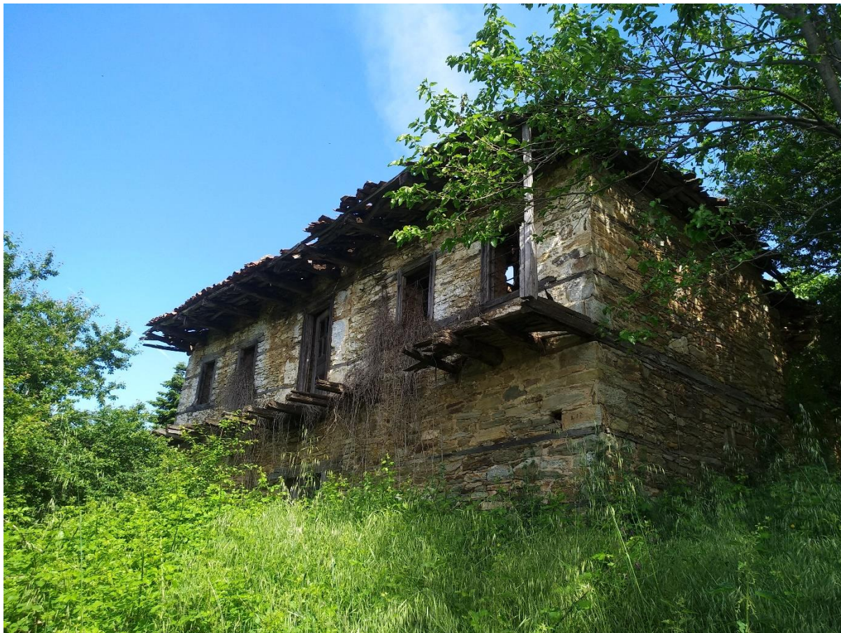
Φωτ. 2 Η νοτιοδυτική όψη του κτίσματος (πρόσοψη).
