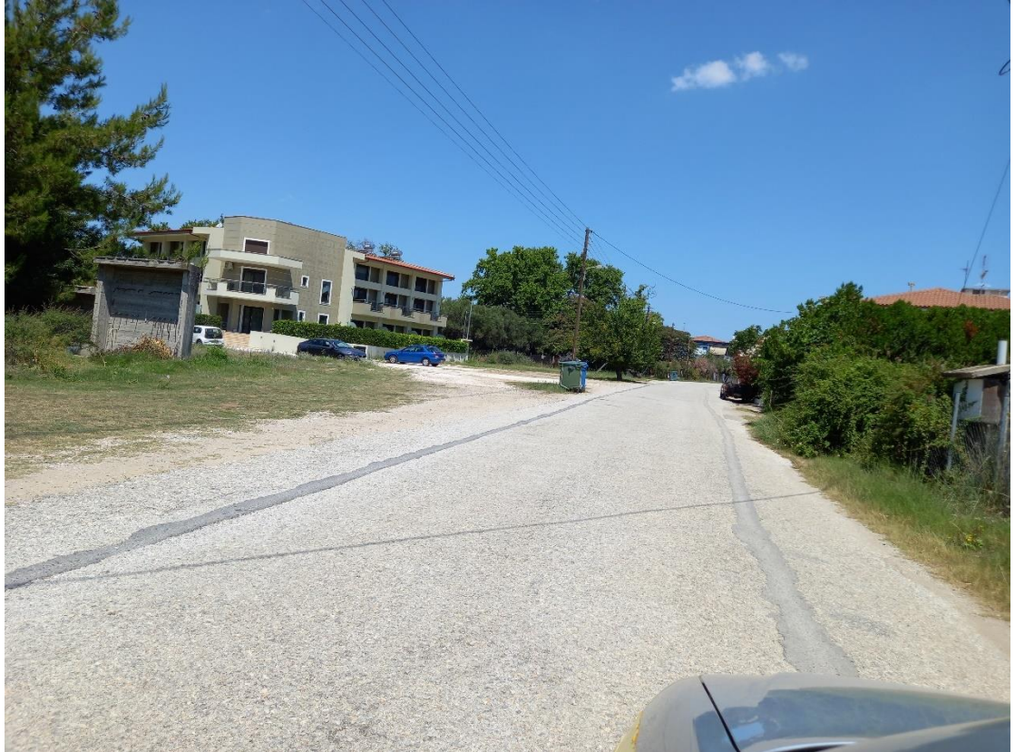
Δυσμενείς έως και επικίνδυνες συνθήκες κυκλοφορίας (υφιστάμενη κατάσταση).
