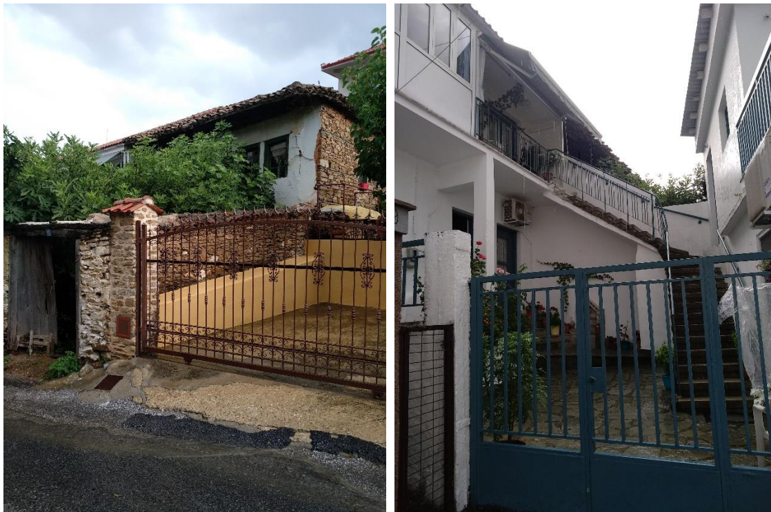
Φωτ. 2 Αριστερά το εξεταζόμενο κτίσμα και Φωτ. 3 Δεξιά εφραπτόμενο κτίσμα – τμήμα της αρχικής κατασκευής.
