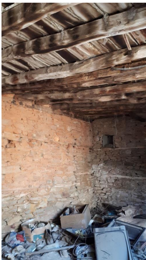
Φωτ. 4. Αριστερά αμφίπλευρη ρηγματώση στην νοτιοανατολική γωνία του ισογείου και Φωτ. 5 Ρηγματώση σε πεσσό του ισογείου.
