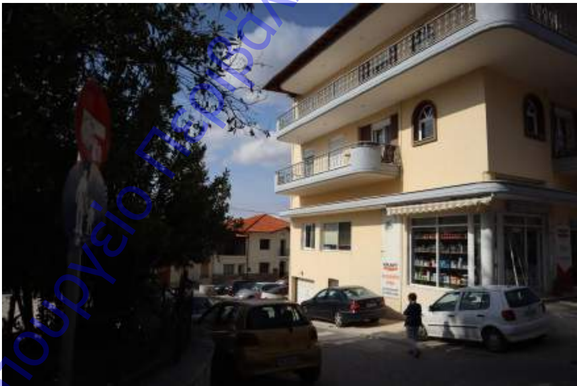
Φωτογραφική αποτύπωση στην περιοχή του Ιερού Ναού Αγίου Νικολάου.
