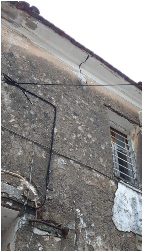
Φωτ. 5 Ρωγμή στέψης στην βόρεια όψη και Φωτ. 6 Φθορές στοιχείων πλάκας σκυροδέματος σε εσωτερικό εξώστη.
