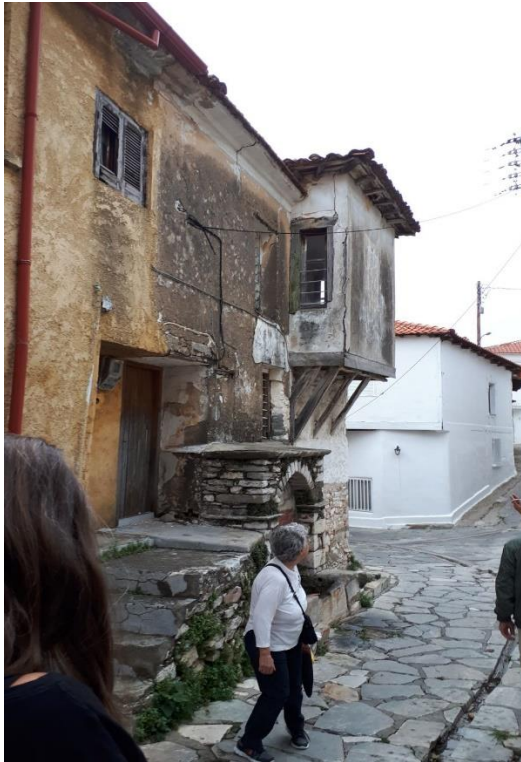
Φωτ. 2 Βόρεια πλευρά κτίσματος και κρήνη
