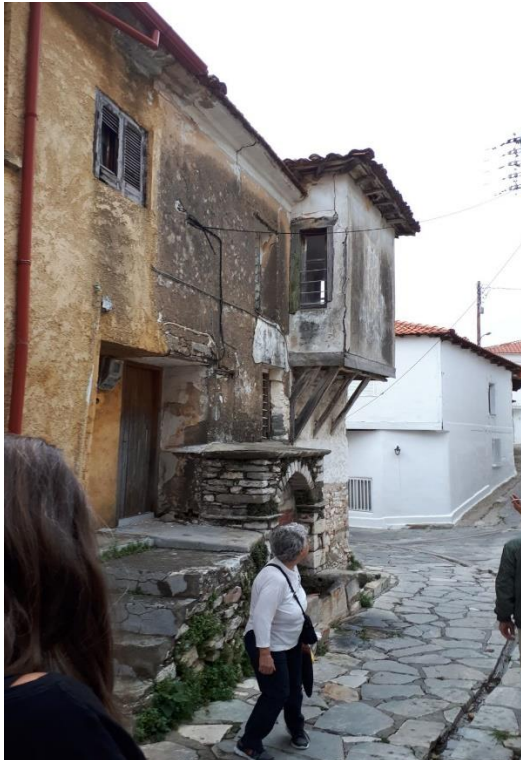
Φωτ. 2 Βόρεια πλευρά κτίσματος και κρήνη
