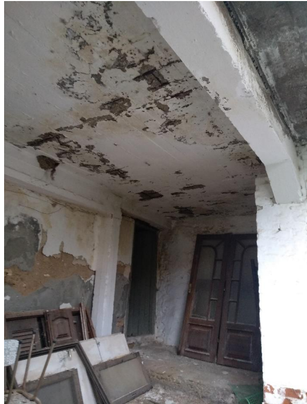
Φωτ. 5 Ρωγμή στέψης στην βόρεια όψη και Φωτ. 6 Φθορές στοιχείων πλάκας σκυροδέματος σε εσωτερικό εξώστη.
